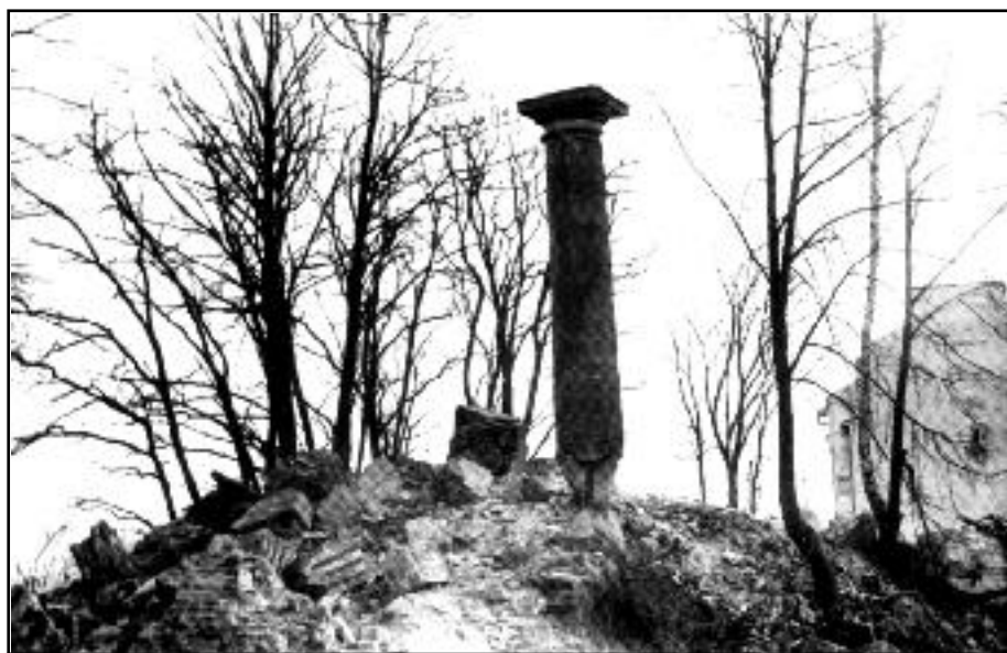
Nr 8. Ocalała po wyburzeniu kolumna kościoła w Zegrzu
